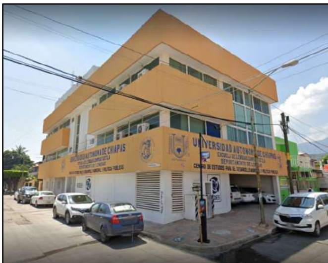
Figura 48. Edificio “CEDES - Departamento de Lenguas Tuxtla”.
